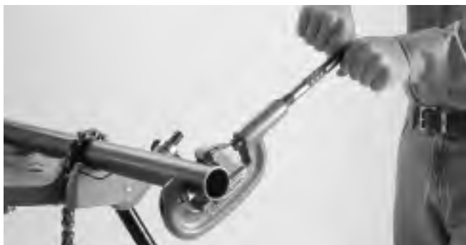
Figure 1 – Coupe de l'extrémité du tuyau
