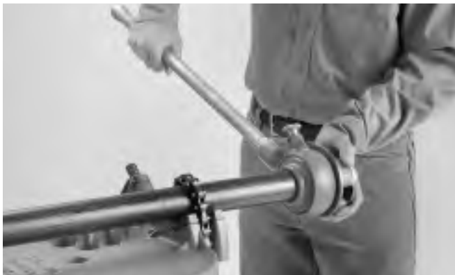
Figura 3 – Montaje de la Roscadora en el tubo
