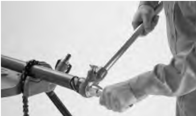
Figura 2 – Escariado del extremo del tubo
